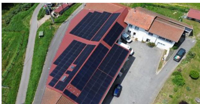
Les salaisons Chalendar, à Beaulieu, disposent d'une capacité de production électrique de 100 Kwc et d'un stockage de 30 Kwc en batteries. Photo fournie par PowerPark
